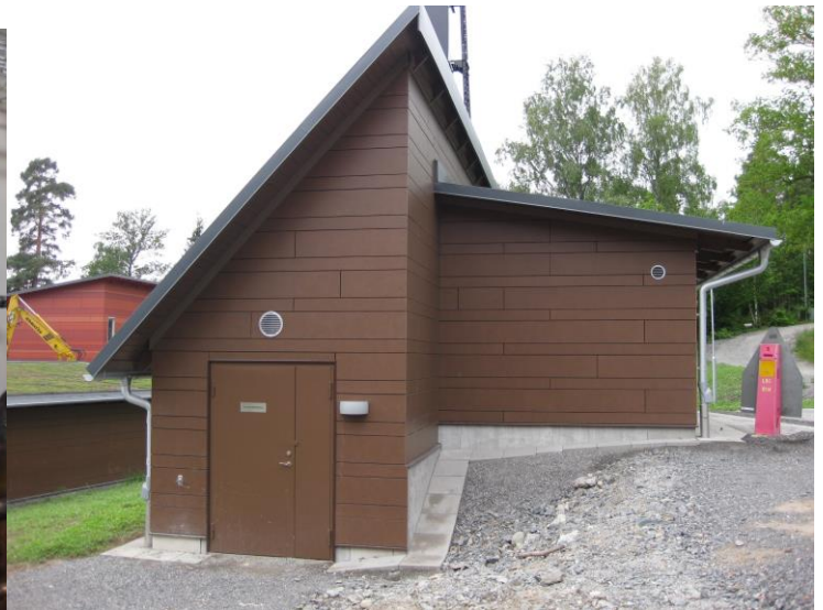
Sala de máquinas
